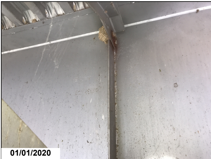
Span 5 g2 dia 4 loose bolts
